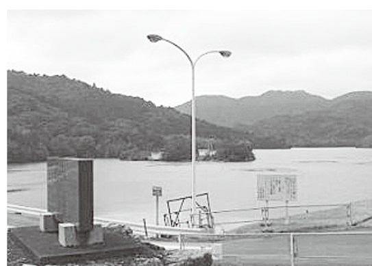
県営志摩水道と統合一元化した市水道水源池
