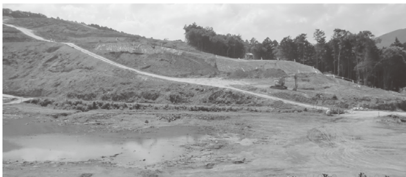
山田地内の建設造成現場
